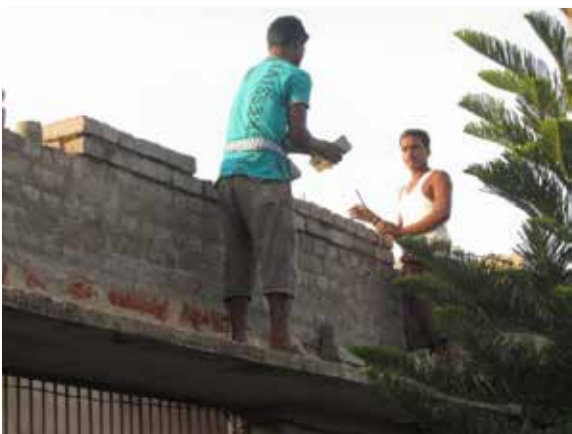
Das Dach im Rohzustand
