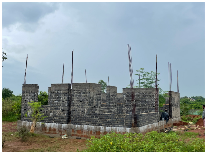
Das Schulungsgebäude im Bau
